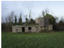
Hkb Hambourg Fermanville (50)
