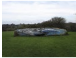
Batterie Westmark St Croix les Delleqs (50)
